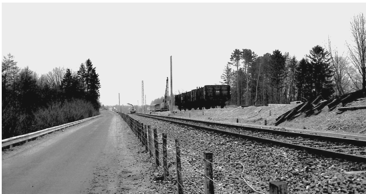
Depotspor under etablering, taget samme sted som A2324 4-2-1975 (A6305)
